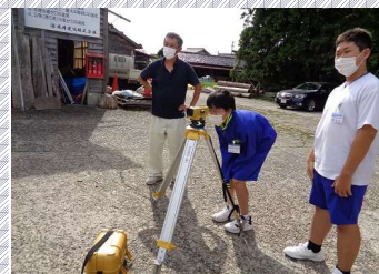
○米井建設 機材を使って本格的な測量を体験しました。
